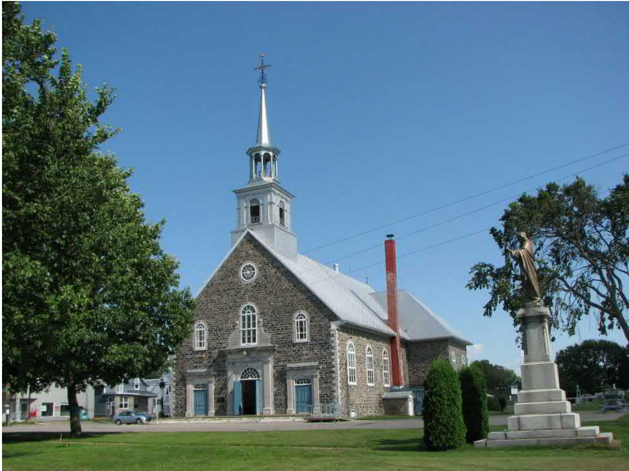
Figure 6 : Les Becquets. Église Saint-Pierre, Thomas Baillairgé, architecte, 1839. Crédit photo : Wikipedia Commons (Dana2255).
